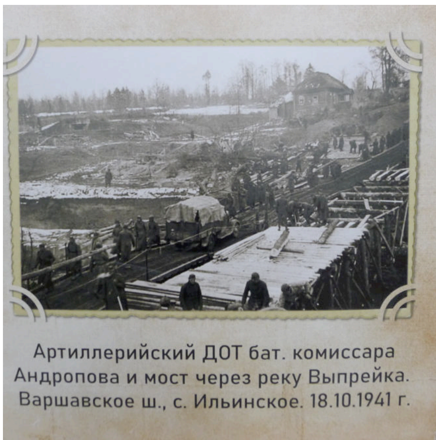
Фото 3. Временная переправа через р. Выпрейку, сооруженная после взрыва моста. Немецкое фото 18.10.1941 г. Вид с юго-запада. Из экспозиции Военно-исторического музея «Ильинские рубежи».
