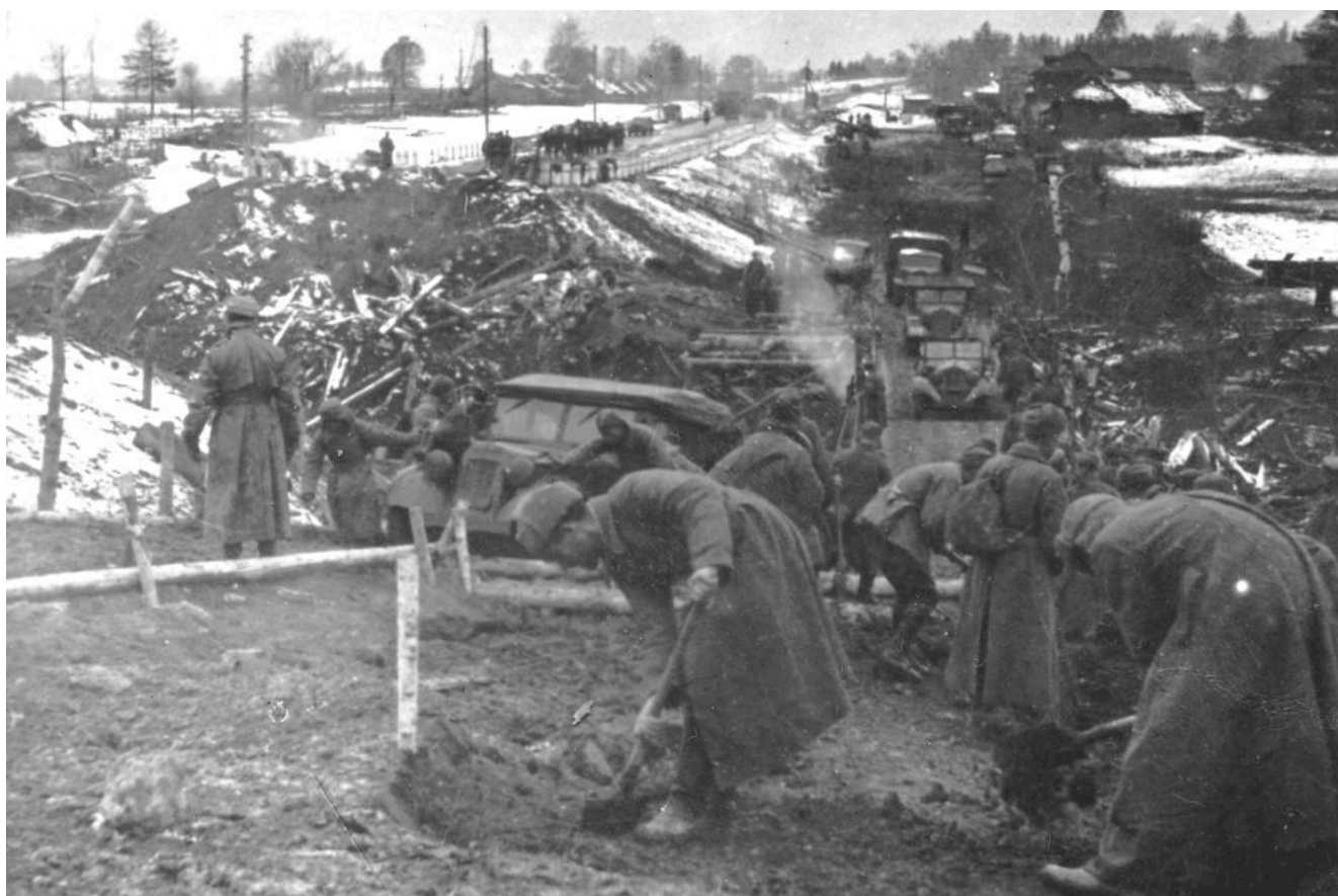
Фото 2. Взорванный мост через р. Выпрейку и временная переправа. Вид с востока. Октябрь 1941 г. Снимок из фондов Военно-исторического музея «Ильинские рубежи».
